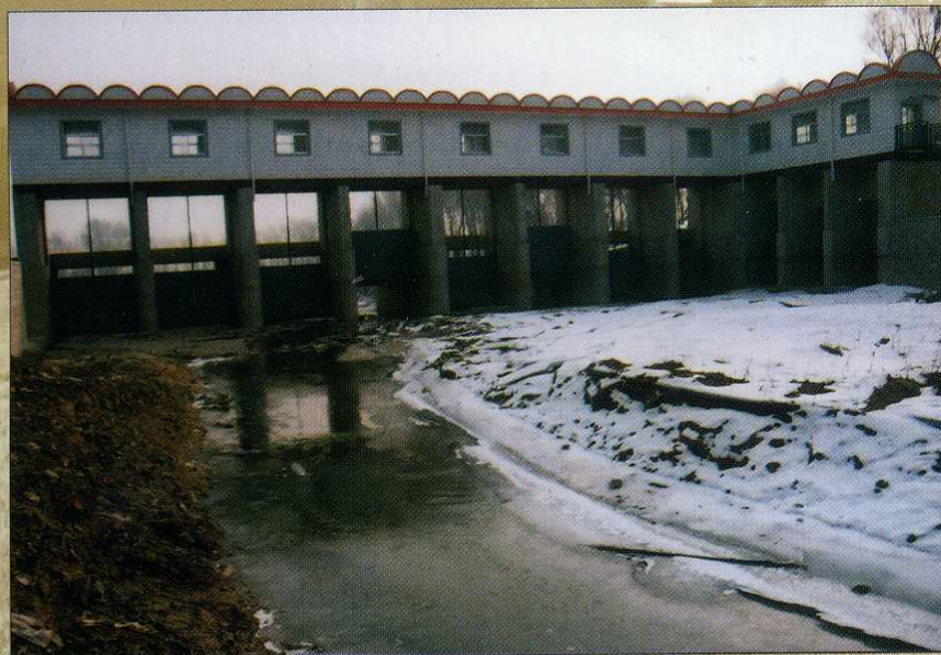
忻定干渠十字闸
