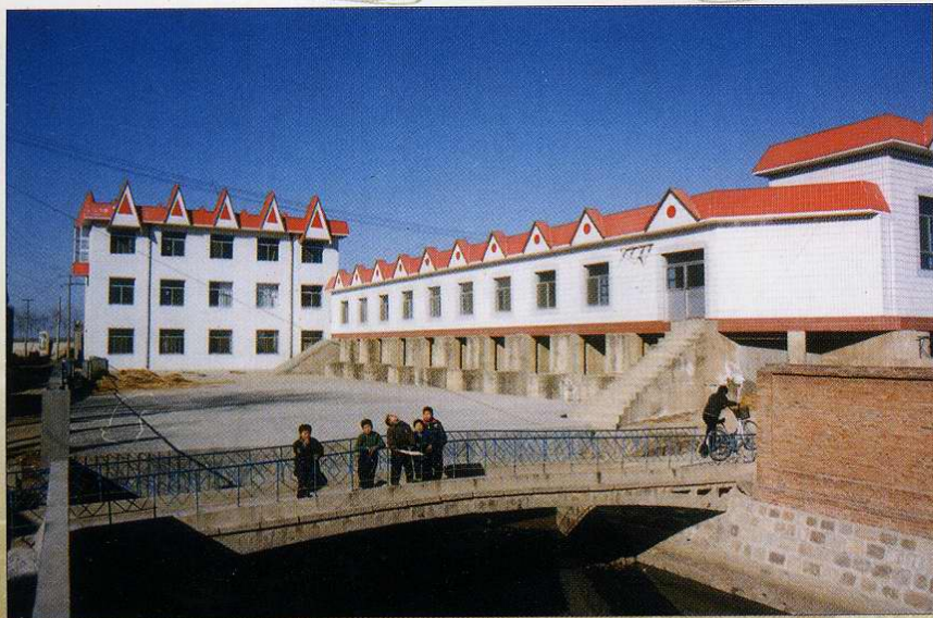
界河铺渠首闸房、 管理房
