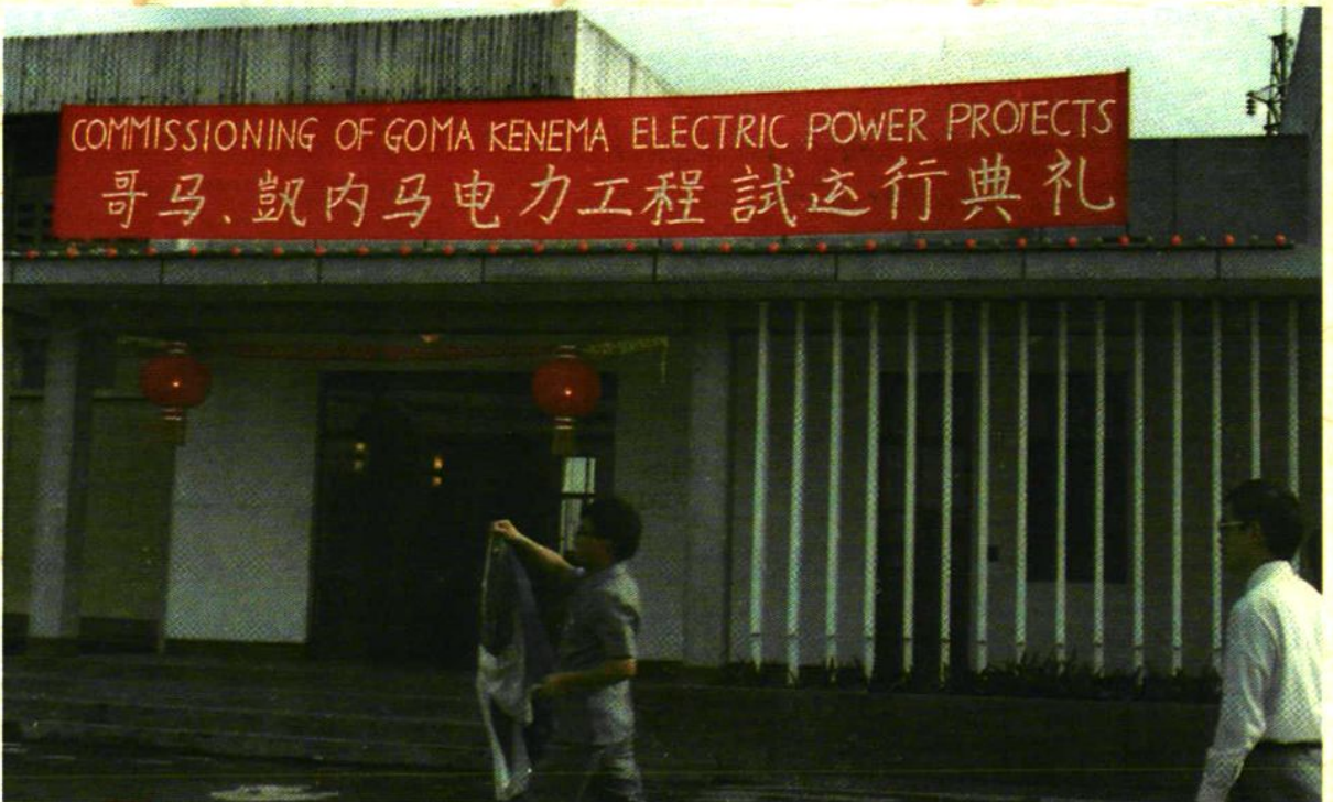
塞拉利昂国哥马·凯内马输变电工程顺利竣工
