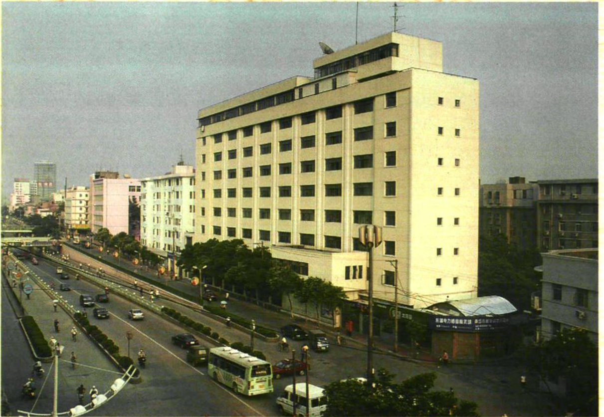
江西省电力设计院办公大楼
