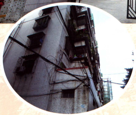
◆ 位于河田路的三元里七社之社员住宅楼。
