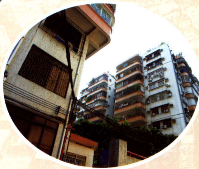
◆ 位于广园中路的八社住宅楼。
