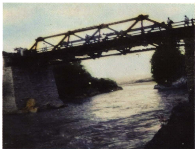
第二次建成的梁链桥
