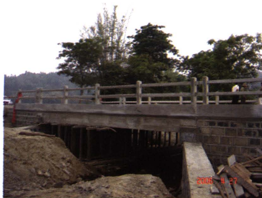
立帕河桥建设
