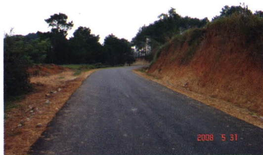
梁河第一条通乡油路——平山油路
