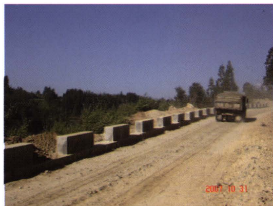
平山公路大中修工程
