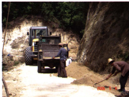
施工中的官丘通乡公路
