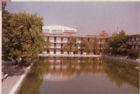
图为利用我队施工的地热井建成的京华温泉游泳池和桑那矿泉浴。
