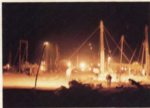
我队在辉县市电厂工地施工基桩。图为夜间施工现场。
