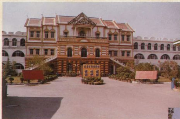
我队地热开发取得了明显的经济效益和社会效益，图为利用我队施工的地热井建成的京华矿泉度假村。
