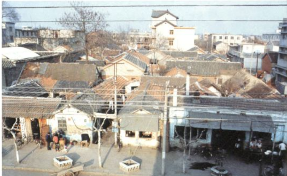
▼ 1988年3月县二轻局楼北侧面貌
