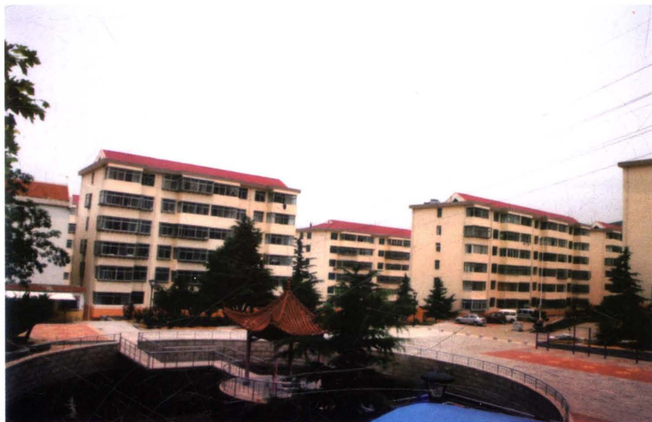
改造后的孙家疃居委会龙泉小区展现新姿，深受小区居民的赞扬。
