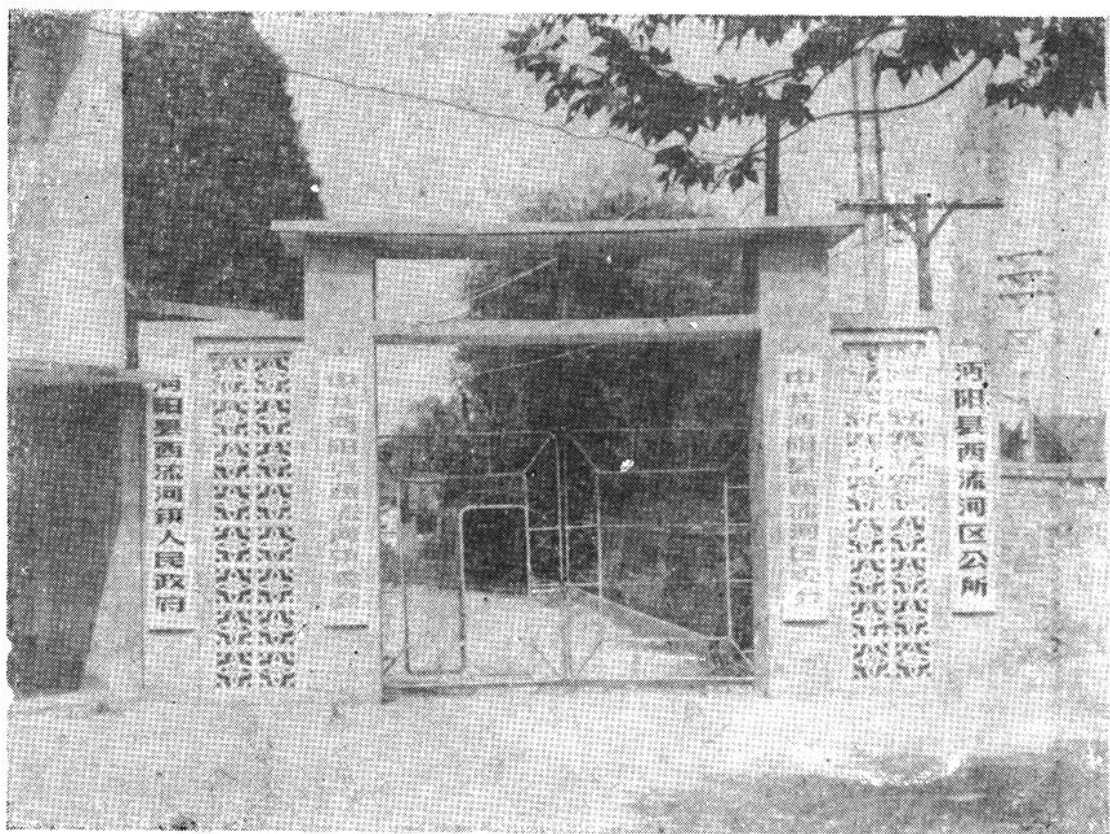
沔阳县西流河区公所，西流河镇人民政府
