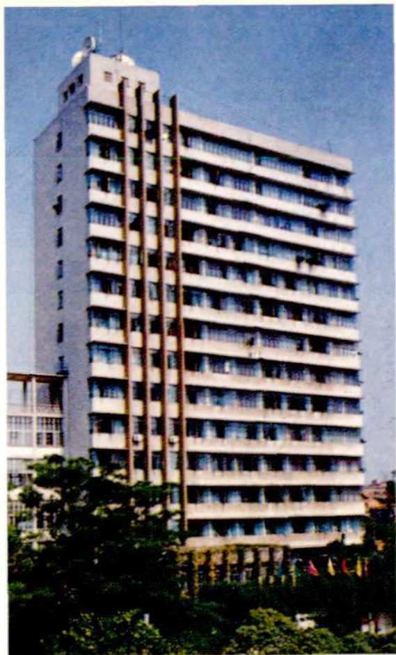
广西电力微波调度楼（民主路）
