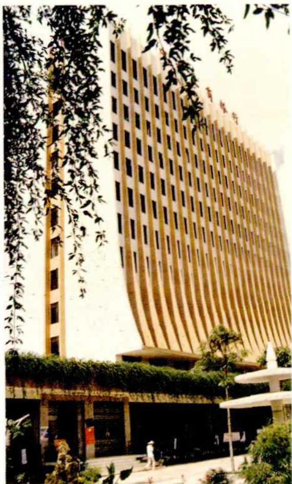
市工商银行办公楼（民族大道）
