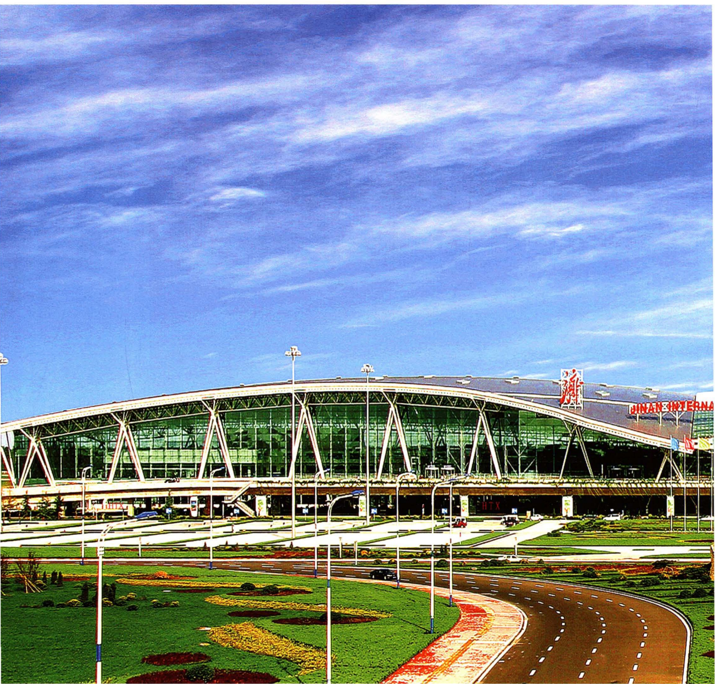
济南遥墙国际机场 (2007年摄)
