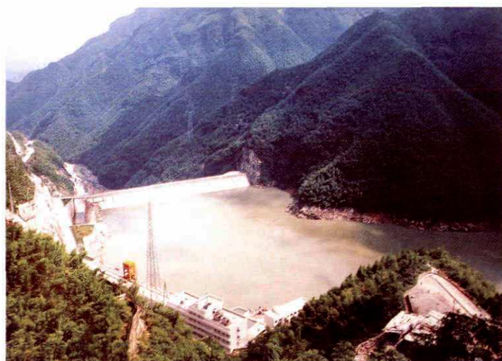
天荒坪抽水蓄能 电站下水库全景
