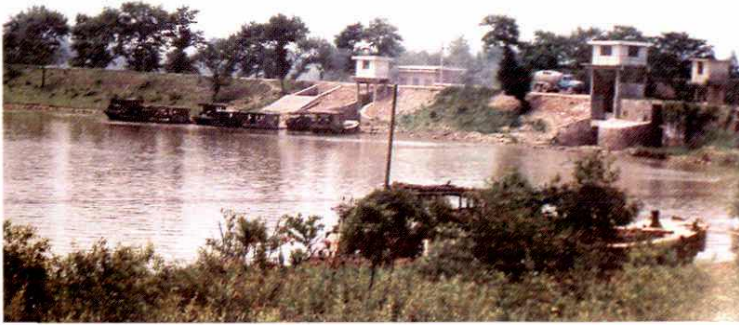
荆湾埭堤（颜村水闸）
