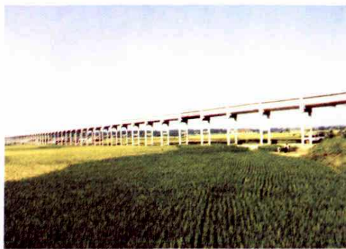
赋石渠道下北寺渡槽
