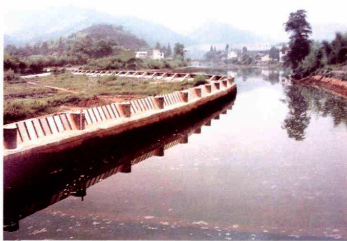
牛黄坝(赋石 渠道进水口)
