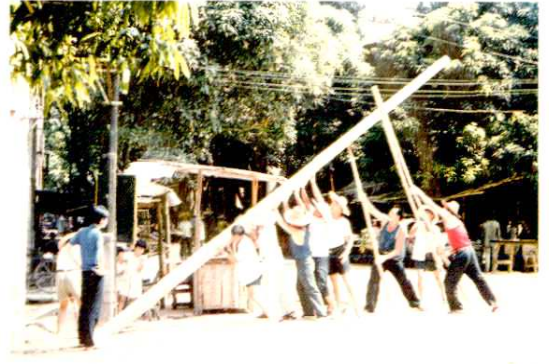
▲ 机线员正在竖立电杆
