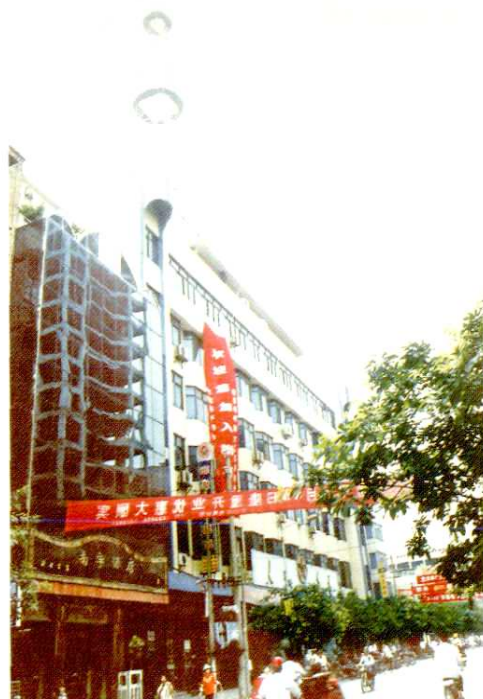
▶ 南洲南路邮电大楼
