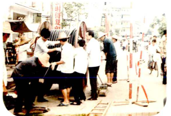
▲ 市话机线员正在布放电缆
