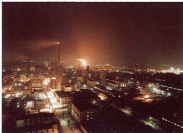
巨化集团公司十里化工城夜景
