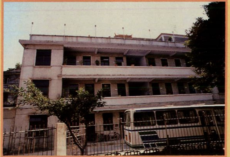
韶关电力工业局送电管理所
