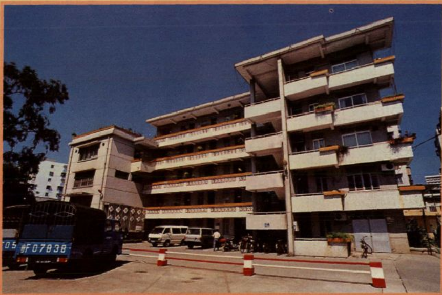
韶关电力工业局变电管理所
