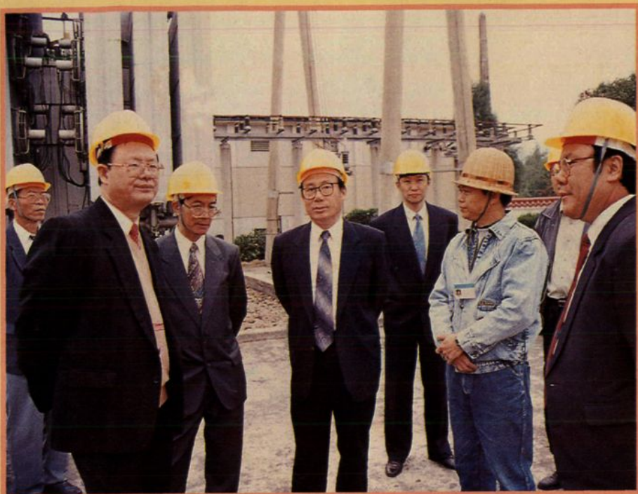
1996年10月15日，电力部陆延昌副部长（中），在广东省电力局吴希荣局长（左二）、韶关电力局徐海山局长（右一）陪同下，在韶关电力局芙蓉变电站视察。
