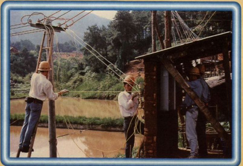
韶关电力工业局向扶贫区送电
