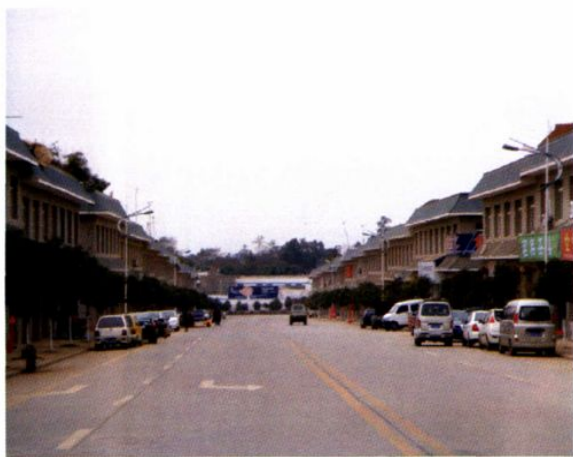
凉水村小区建设
