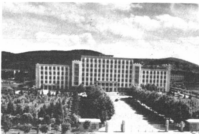
市人民政府大楼
