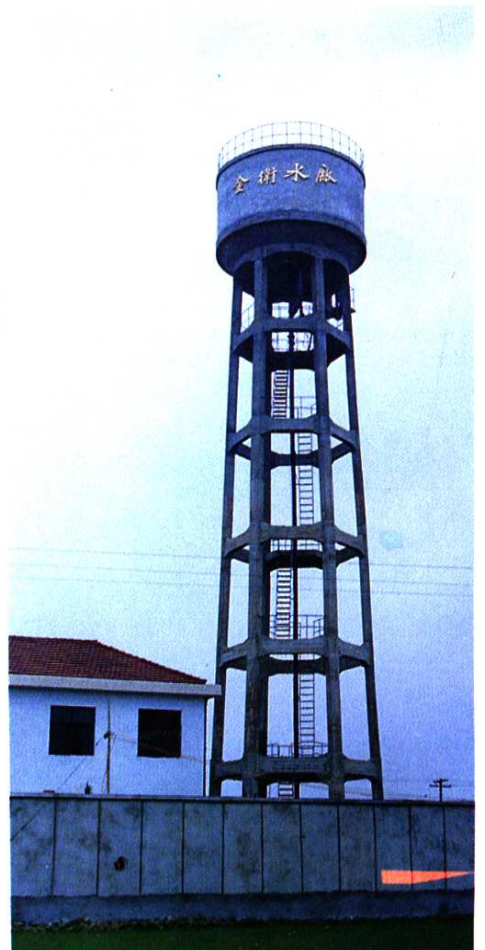
▼ 金卫水厂第一座深水井塔。
