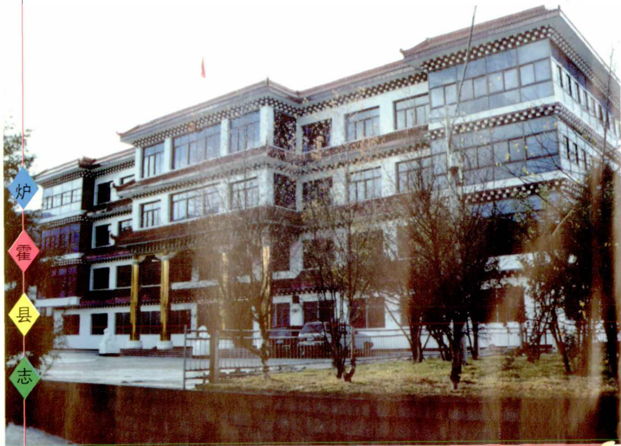
政府办公大楼
