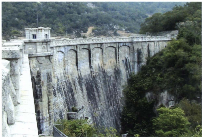
◀ 上里水库大坝
