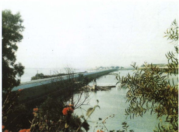
▲ 九龙江北溪引水左干渠工程（厦门段）高崎渡槽
