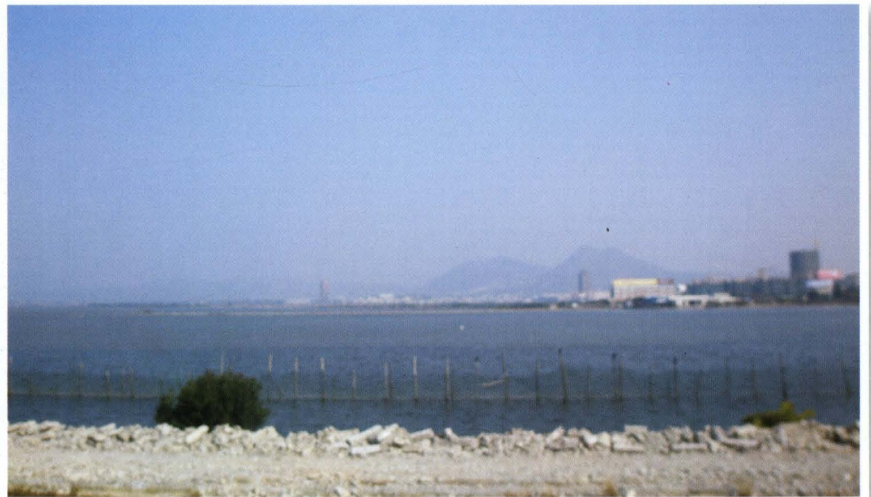
▶ 杏林湾水库坝区
