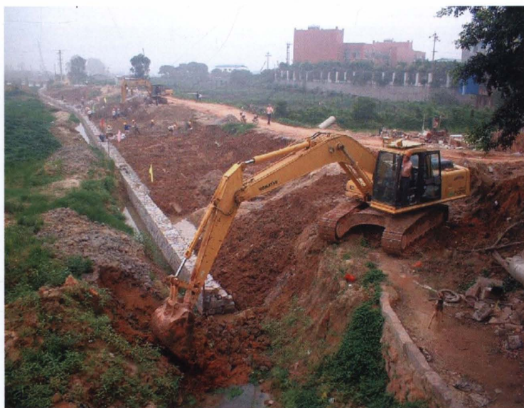
► 官浔溪治理工程施工场面
