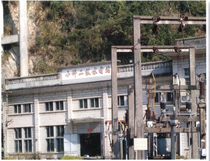
▲ 小平二级水电站
