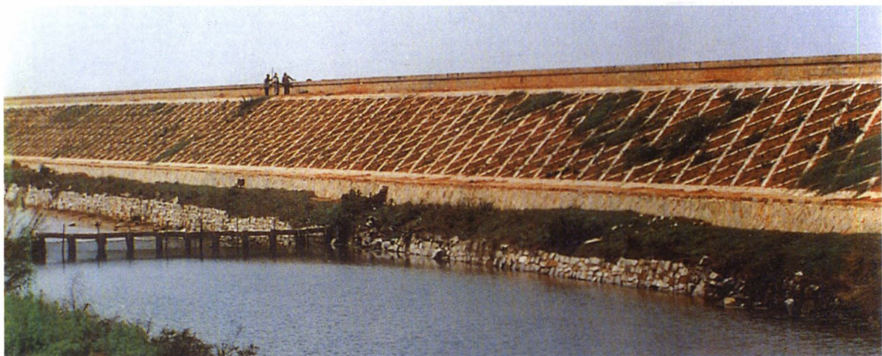
▼ 东坑海堤坝内坡条石网络护坡
