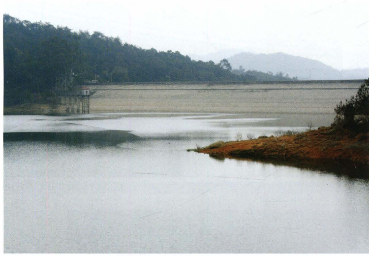
◀ 石兜水库坝区
