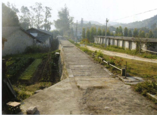
▲ 一支渠供水暗涵
