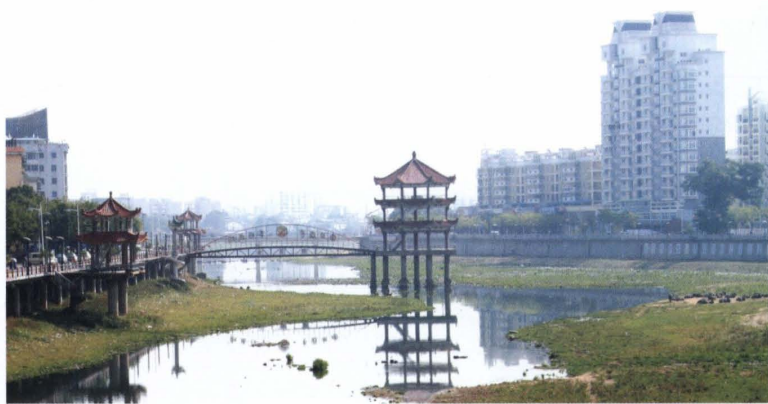
► 东西溪防洪体系工程
