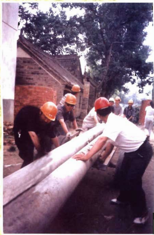
城网改造施工现场
