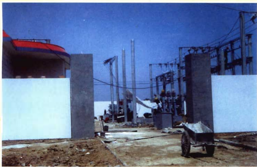
正在建设中的穰东变电站
