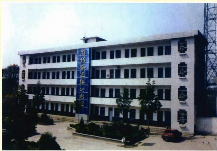
邓州市电业局办公大楼
