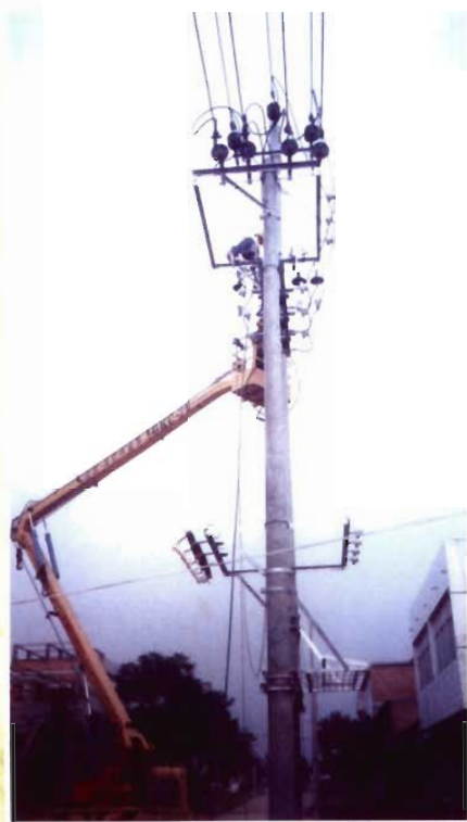
城网改造安装调试现场
