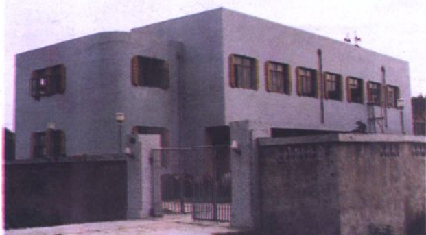
亭林邮电支局机务楼
