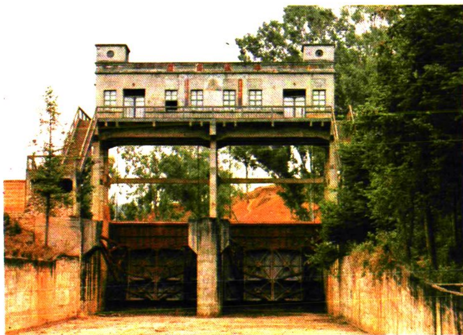
蒙自庄寨水库溢洪闸
