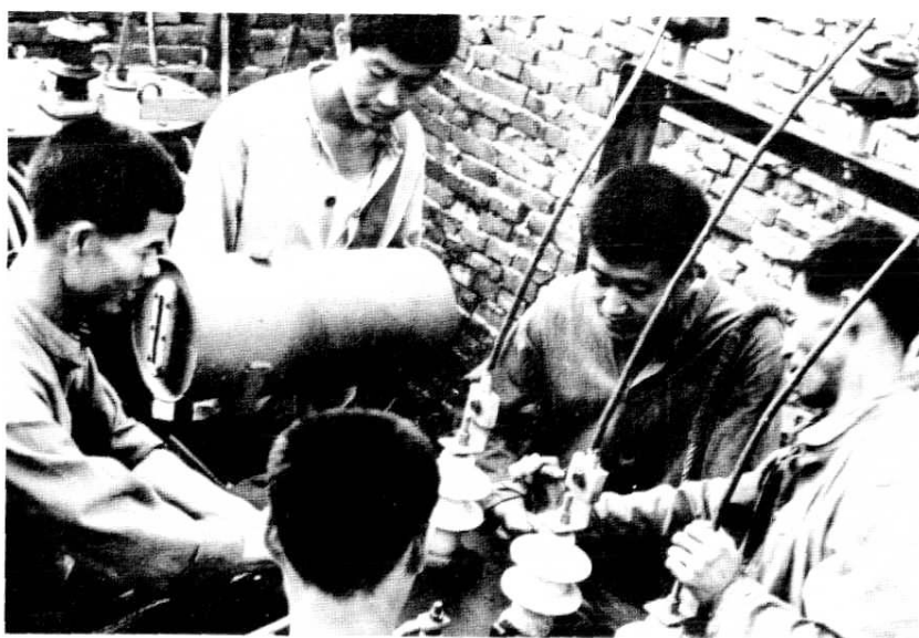
电仪工人在安装
