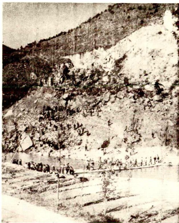
开山采石修铁路
