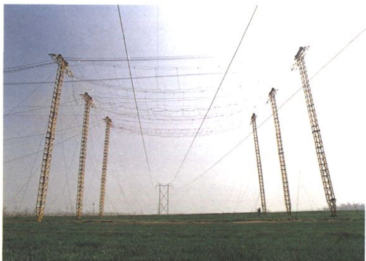
■带电跨越新技术在线路施工中广泛应用。
