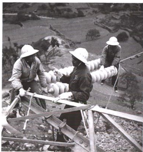
■1975年220千伏莱芜—济南输电线路施工。
