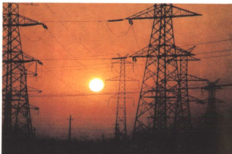
■山东省第一条220千伏输电线路莱 芜发电厂至淄博魏家庄变电站输电 线路于1973年12月建成投产。
