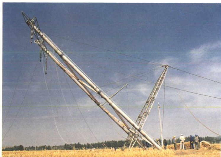
■220千伏线路立杆施工。
