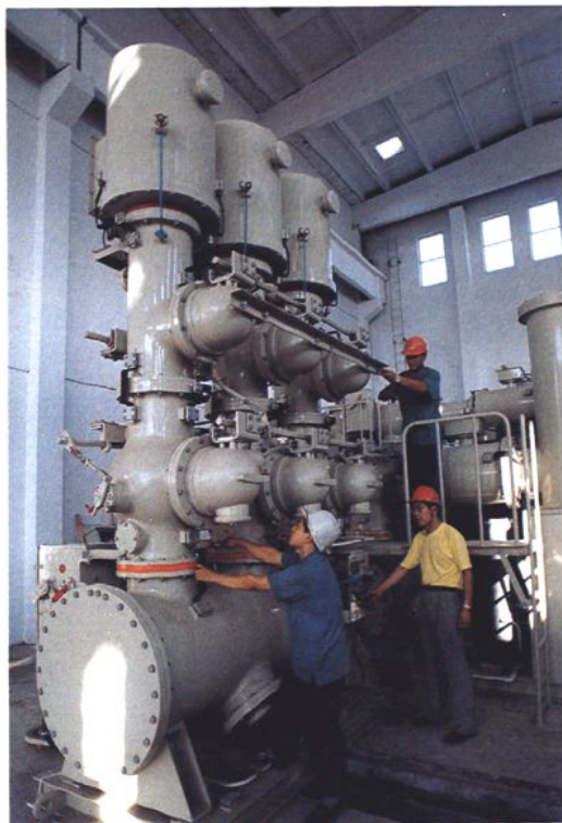
■ 山东省第一座220千伏全户内变电站涝台变电站组合电器安装调试。
