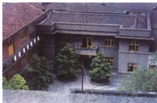
检察院原办公楼
