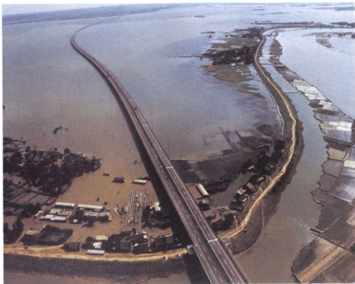
赣粤高速公路（药湖大桥）
