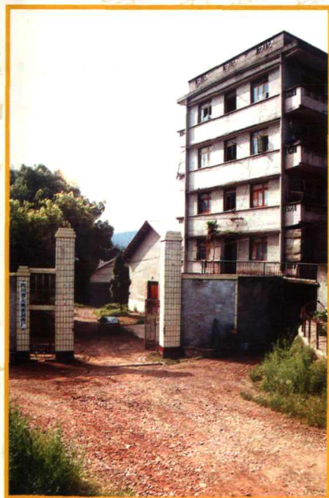
图为公司川密厂正大门一角。
