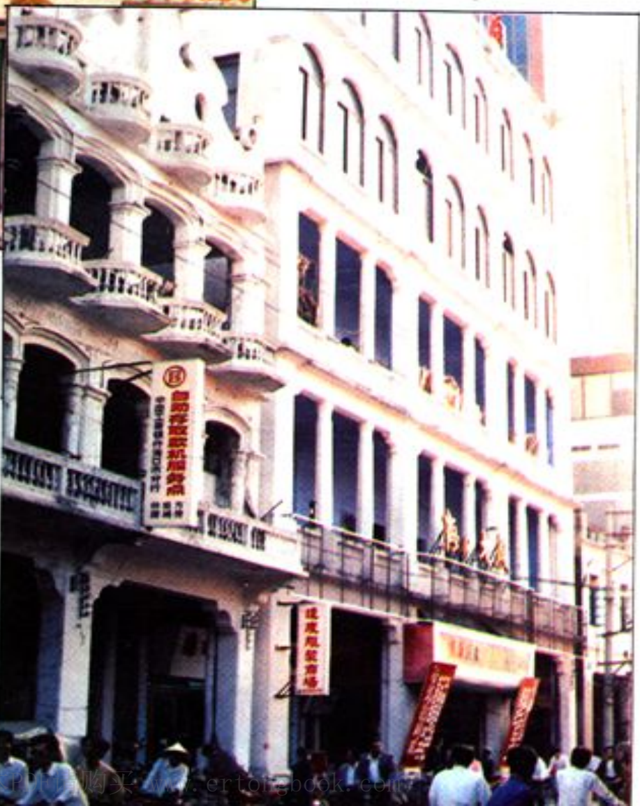
建成的海口大厦 ▶
