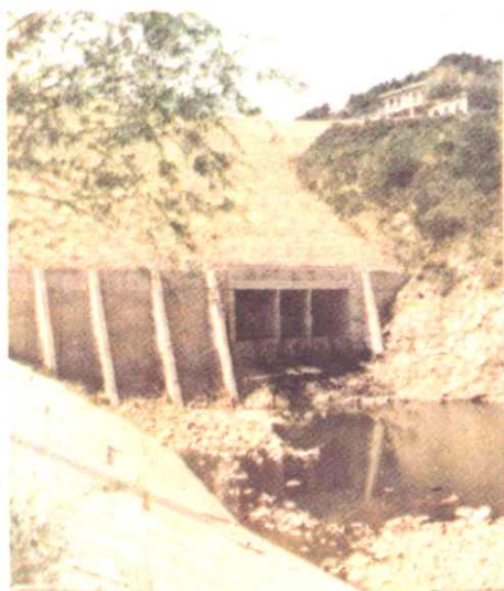
水库泄洪洞出口 (摄影齐继翔)
