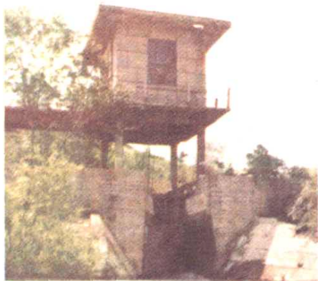
水库输水洞出口启闭室 (摄影齐继翔)
