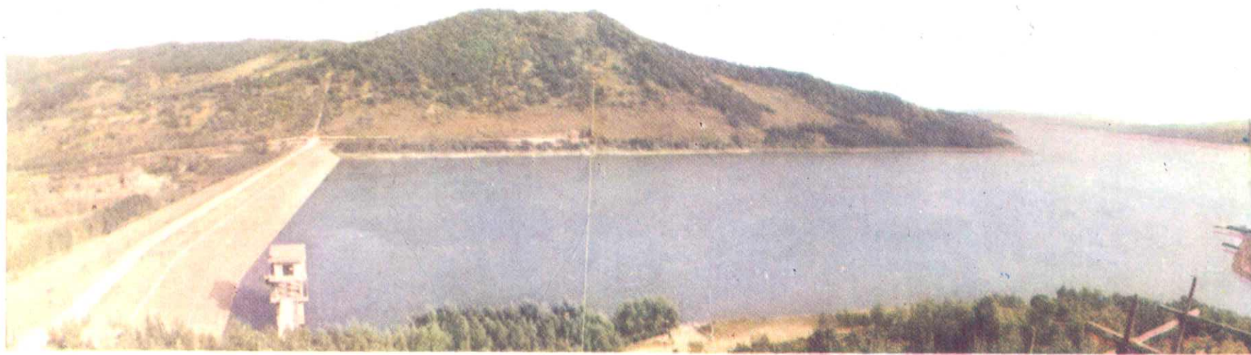
星星哨水库全景
