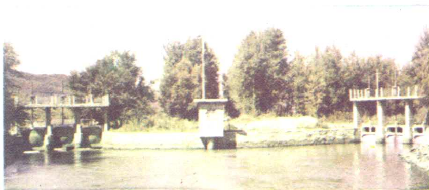
星星哨灌区总干渠首分水闸 (摄影齐继翔)
