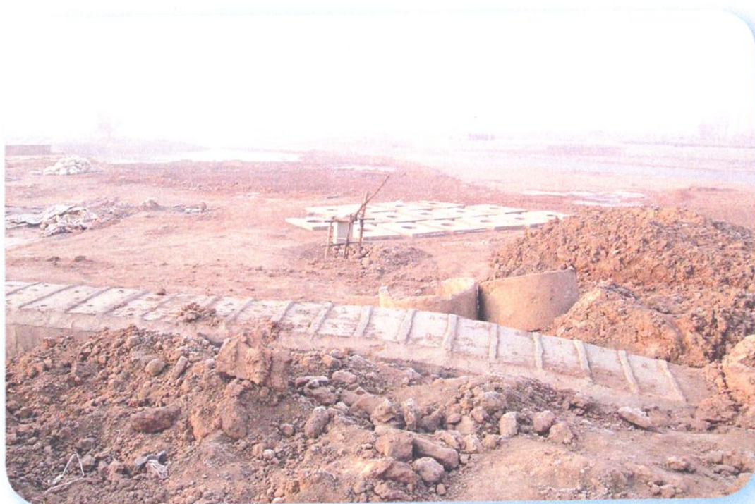
景观水道（上海路以北）东侧扩挖
