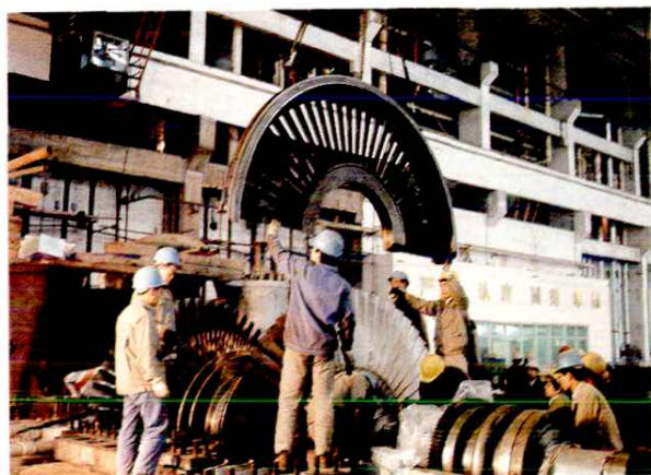
22 1990年，遵义发电厂扩建的第一台12.5万千瓦机组正在安装
