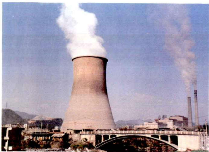
23 1989年，贵州电力建设一公司承建的贵阳电厂3500平方米冷水塔，获省优质工程称号
