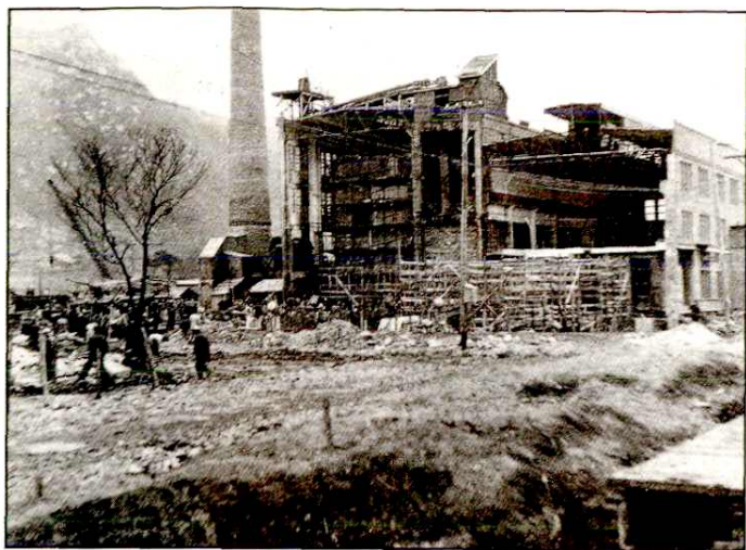
14 1958年,贵阳电厂(赤马殿)工地
