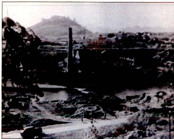
8 1939年3月投产的贵阳电厂(水口寺)一机房,装机 2 \times 160 千瓦。摄于1939年
