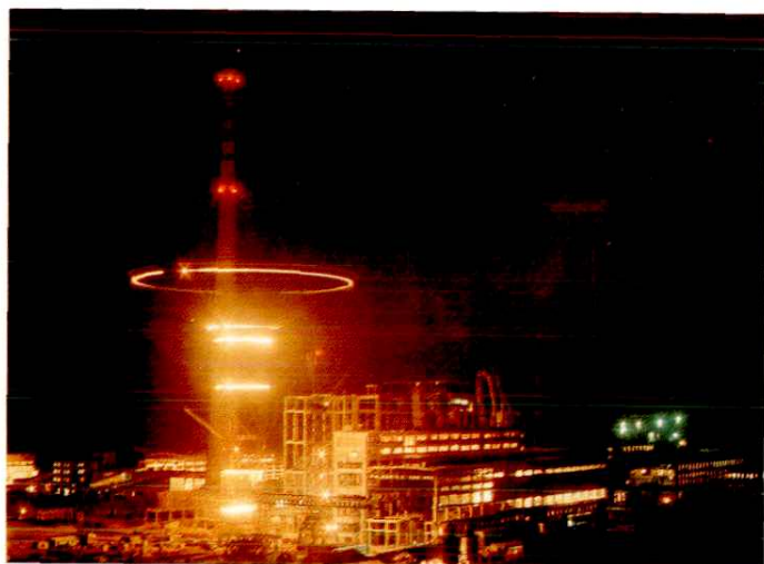
15 1987年,清镇发电厂三期扩建(2×20万千瓦)工地
