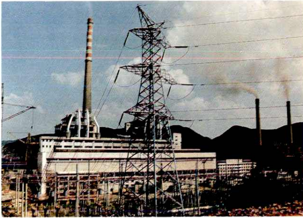
35 清镇发电厂 2 \times 20 万千瓦机房
