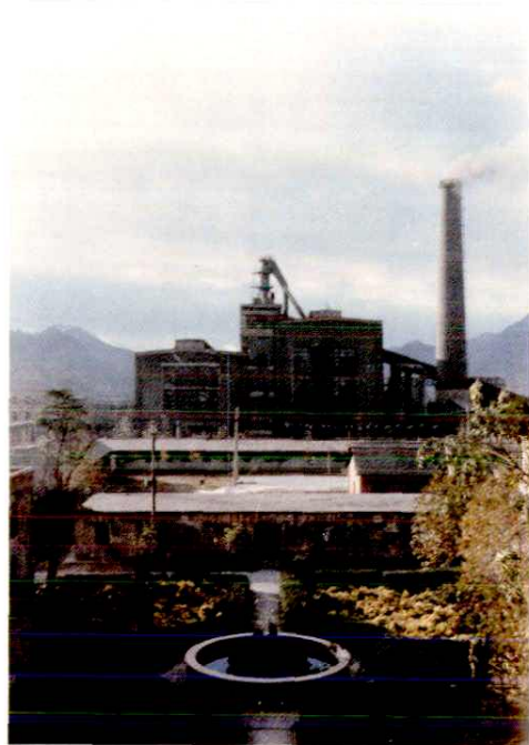
32 都匀发电厂, 装机5×6000千瓦
