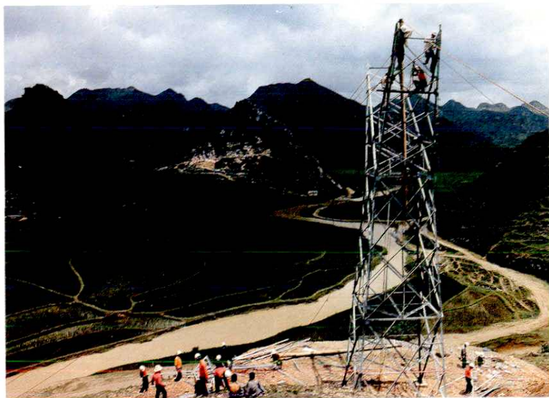
19 1988年，贵州送变电工程公司职工在深山中架塔
