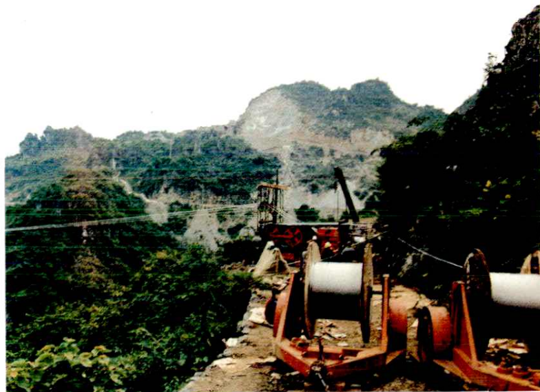
20 1990年，贵州第一条500千伏高压输电线路正在架设
