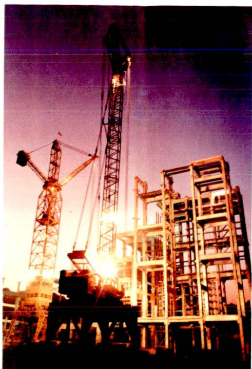
24 1990年，盘县电厂(3×20万千瓦)建设工地
