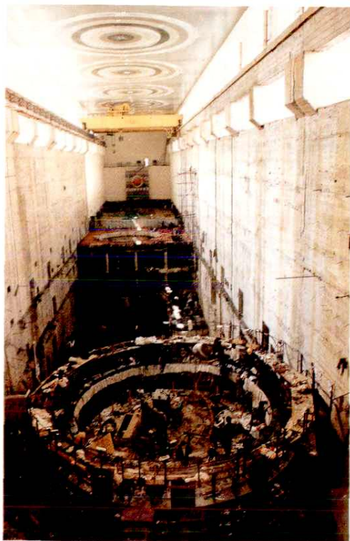
18 1990年,天生桥二级电站机组正在安装
