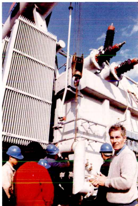
29 1990年，意大利专家在500千伏贵阳变电站指导安装主变压器
