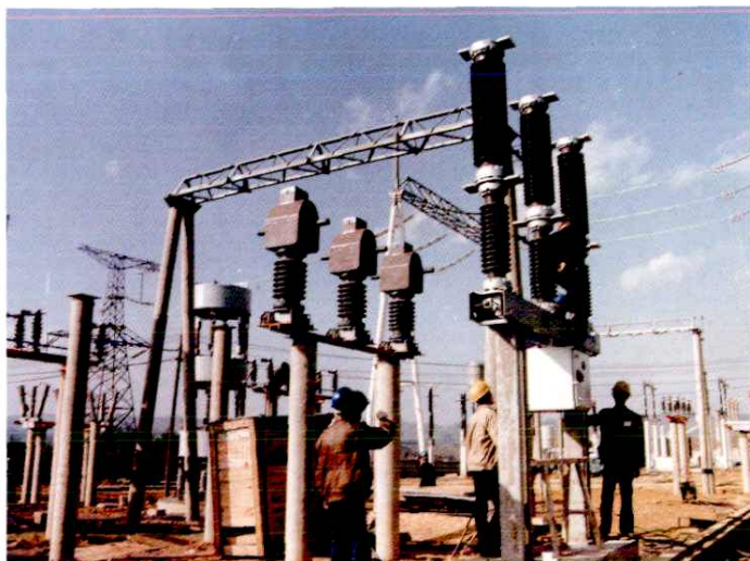
28 1990年，500千伏贵阳变电站在建设中
