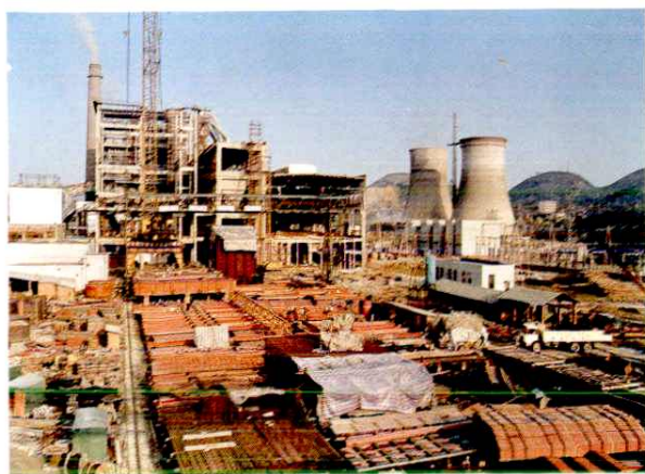
21 1990年，遵义发电厂扩建工地
