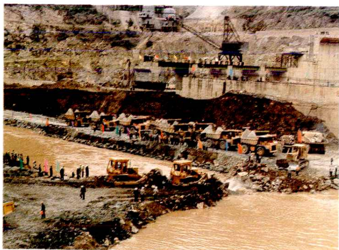
17 1986年11月19日,南盘江天生桥二级电站(6×22万千瓦)一次截流成功
