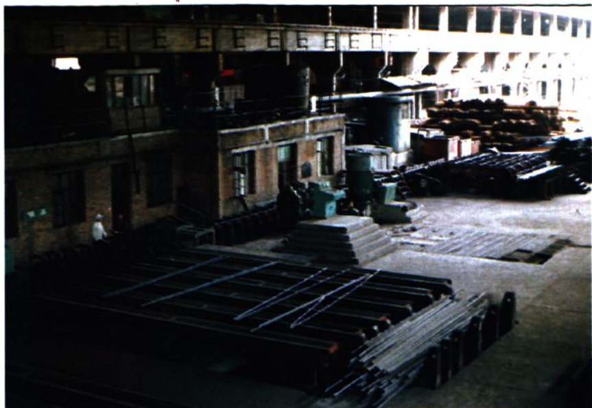
▲ 高压水射流钢坯除磷生产线
