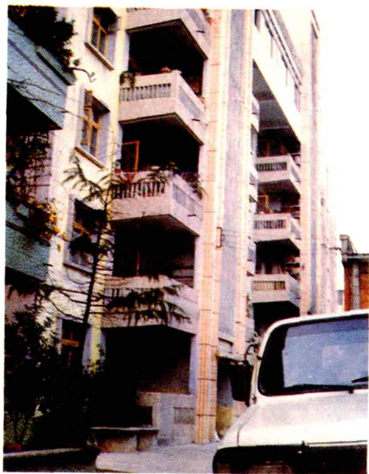
梓潼县供销社职工宿舍大楼
