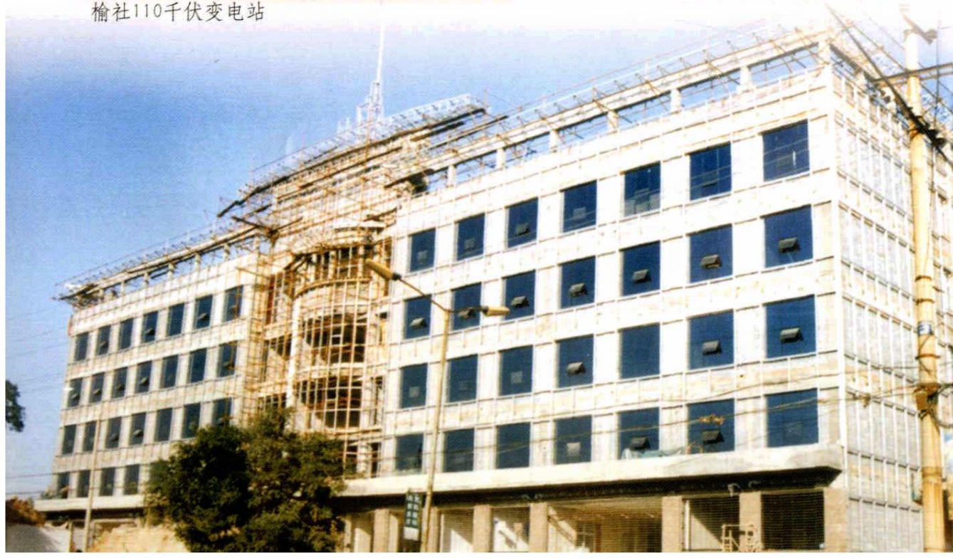
2005年建设中的生产综合调度楼
