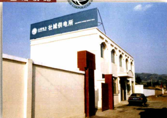
社城供电所办公楼
