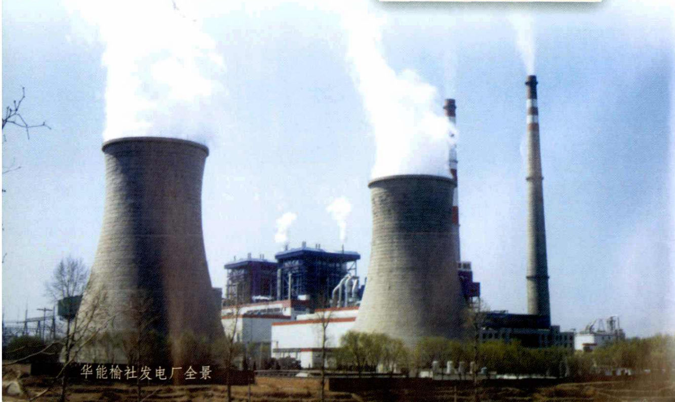
榆社县发电厂旧址
