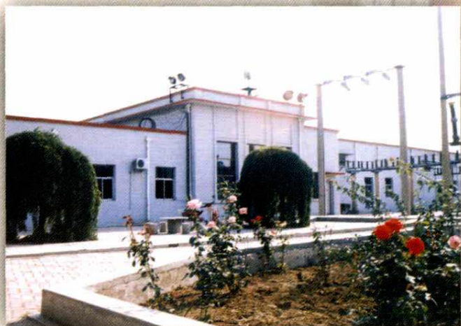
榆社110千伏变电站
