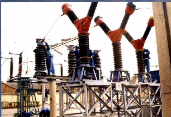
变电站设备清扫
