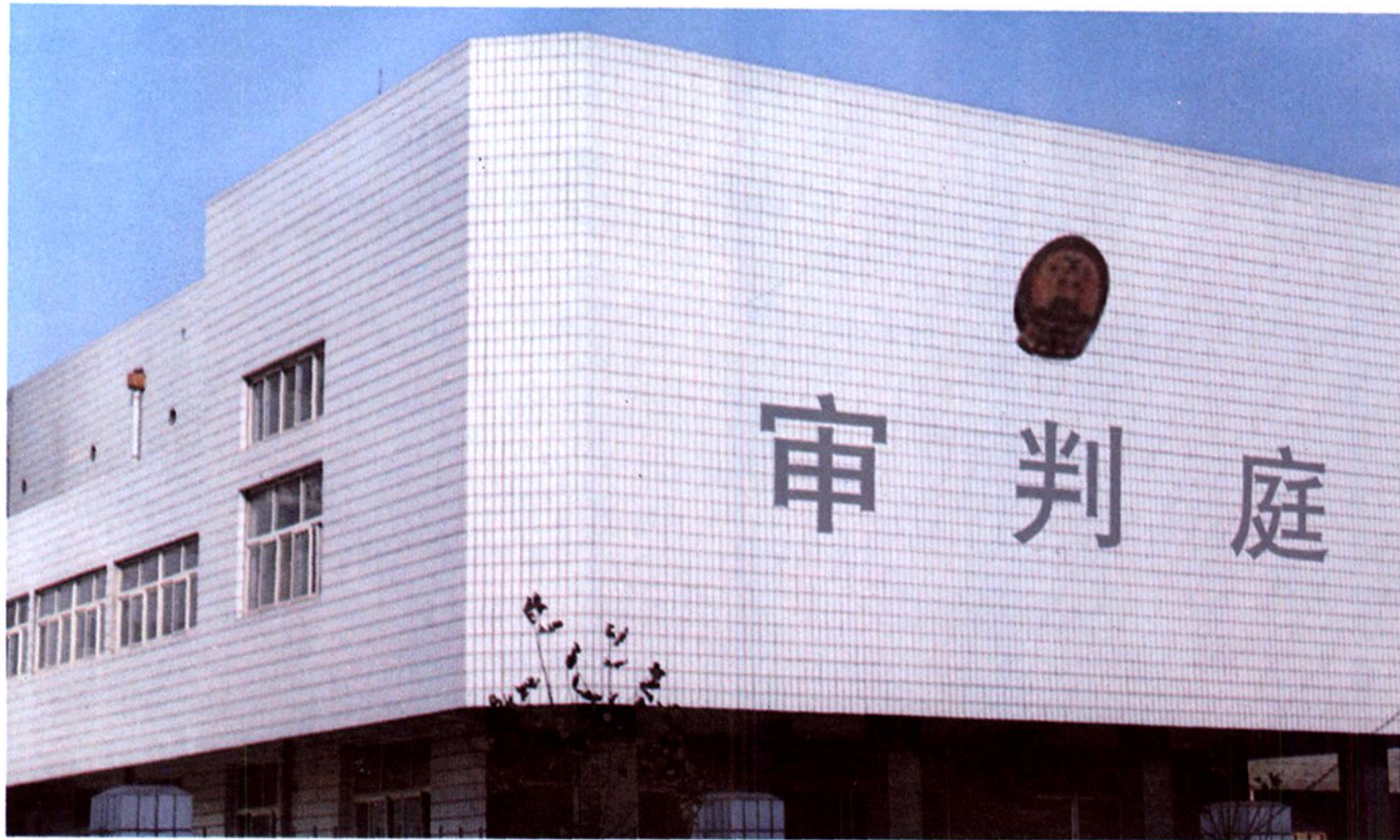
河北省井陉矿区人民法院法院审判大楼
