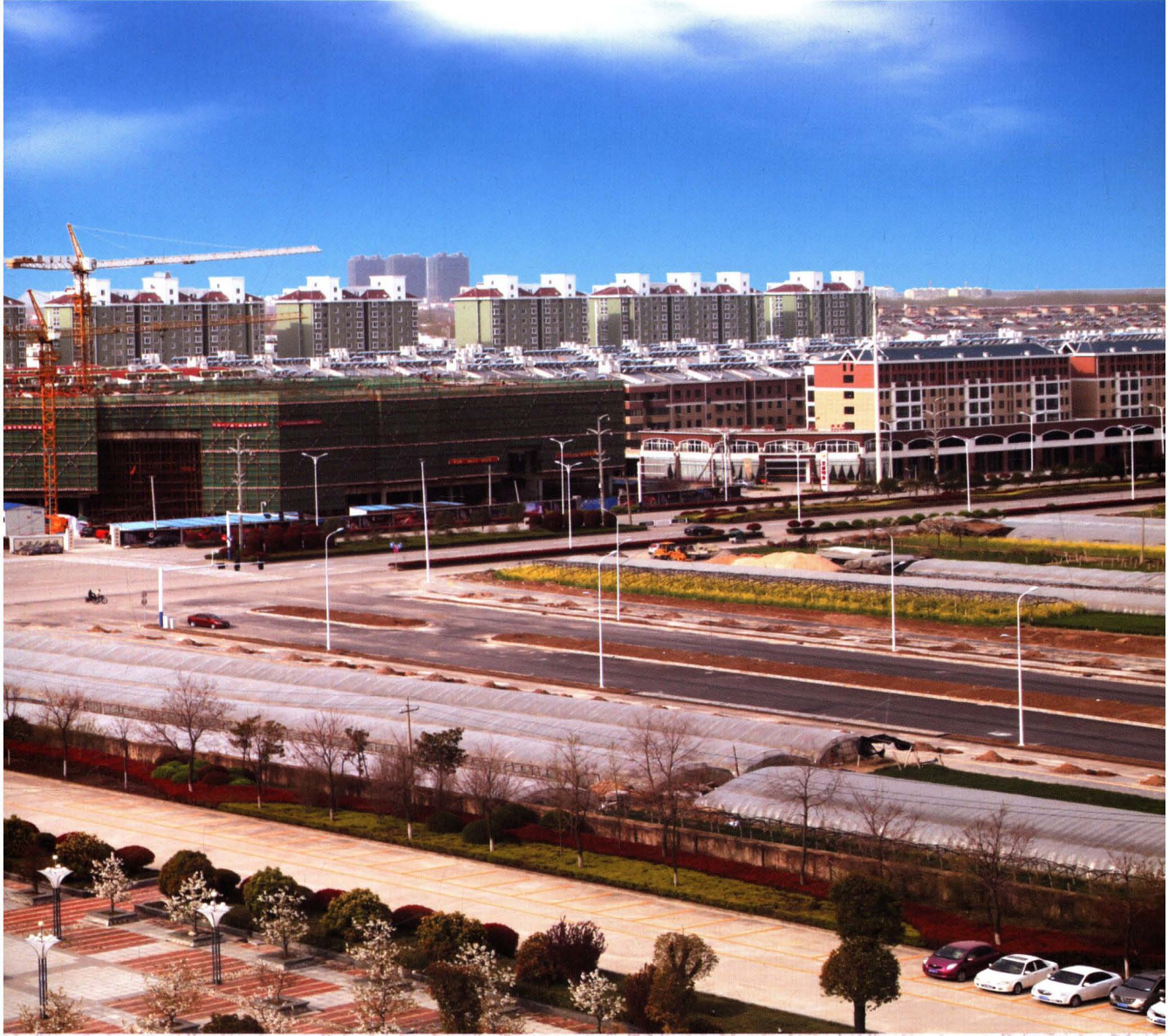
正在建设中的殳城新区一角 (2014年 摄)
