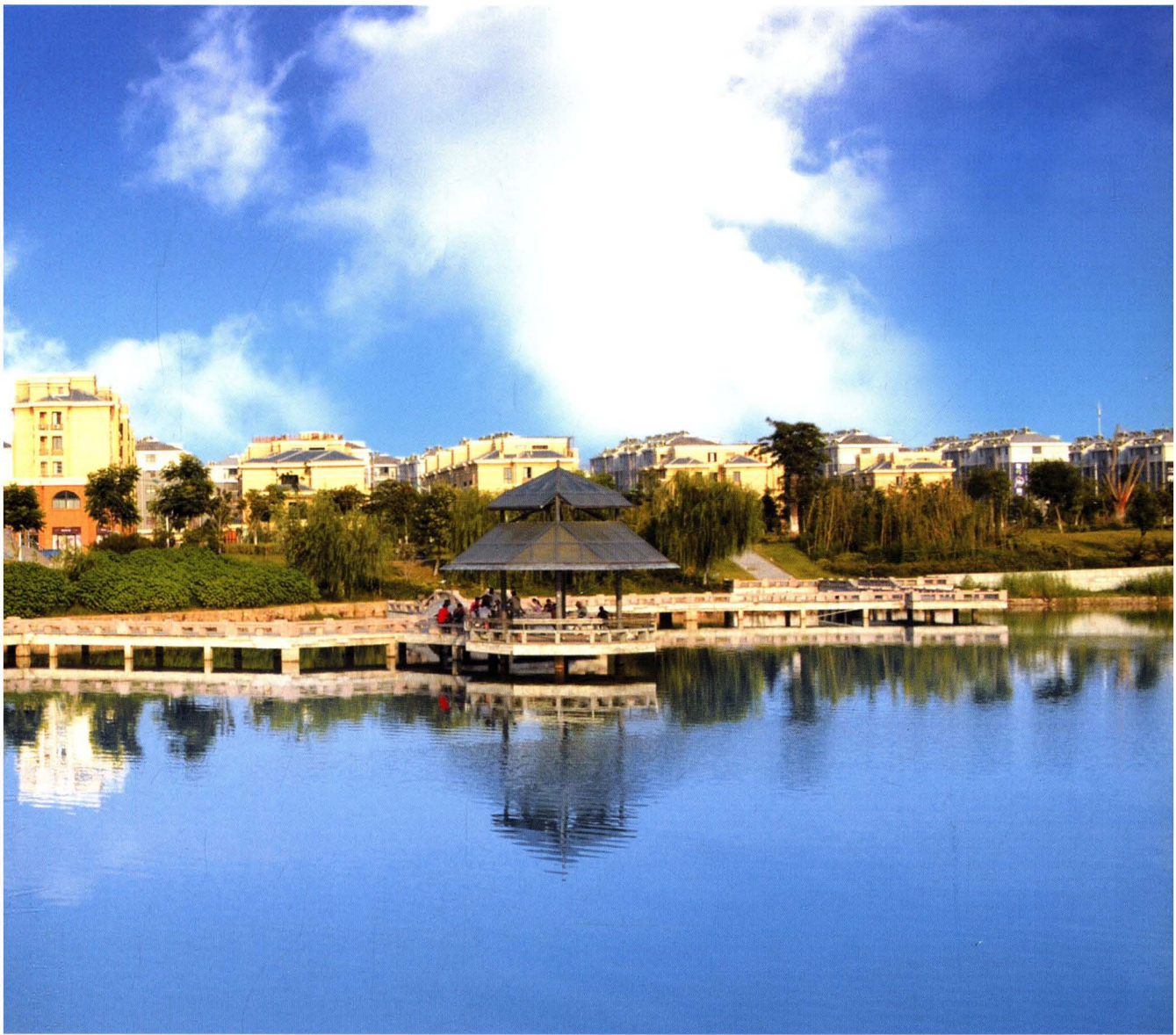
位于环城河北侧的帝景水岸 (2014年 摄)
