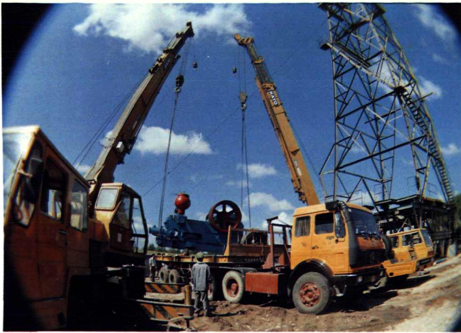
钻井设备 搬迁吊装
