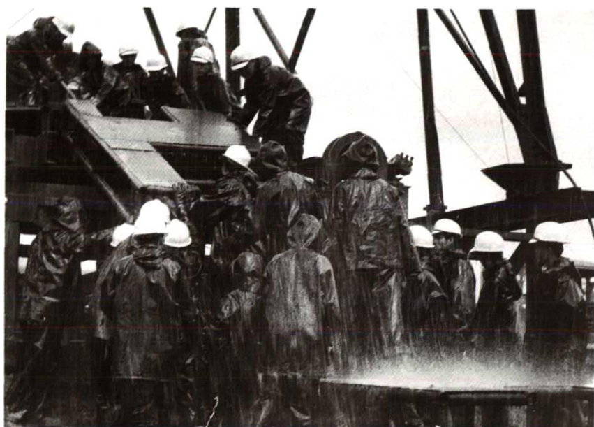
井队冒雨安装设备
