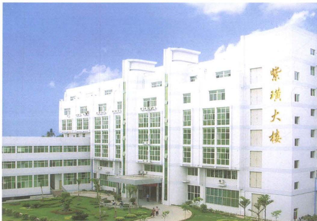
涵江医院紫璜大楼
