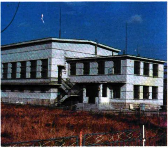
浑河一次变主控制楼
