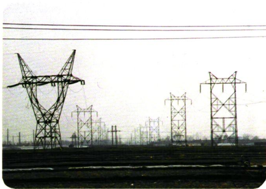
220 千伏李灯线(左)浑鞍线(右)
