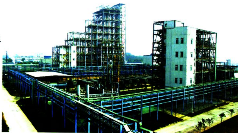
四川新光硅业科技 有限公司生产现场
