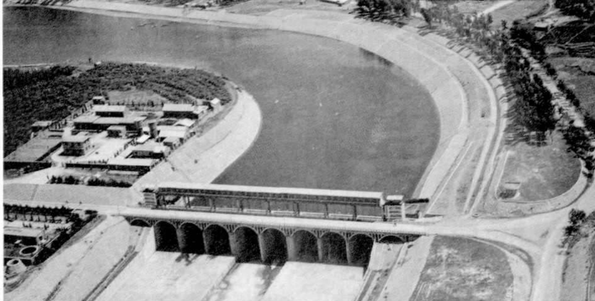
▶ 于桥水库溢洪闸
