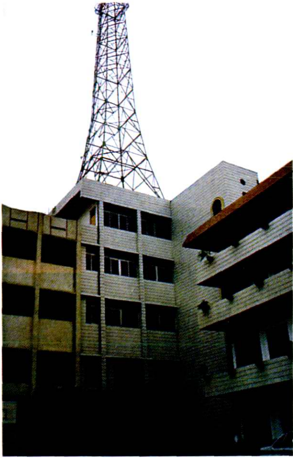
上犹县电信大楼
