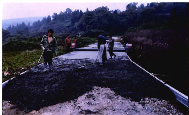
通村公路施工
