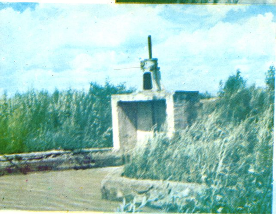
西干渠进水闸
