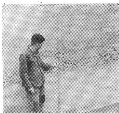
李香林科长检查泄洪洞混凝土浇注质量
