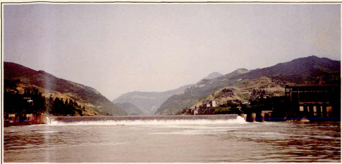
▲ 舵石鼓闸坝为全国第一座高水头溢流堆石坝，右端舵石鼓电站为全省第一座大河发电站
