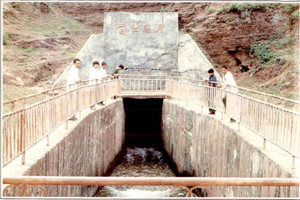
▲ 沙滩河水库右干渠穿越巴河 1810 米的倒虹管的压力前池
