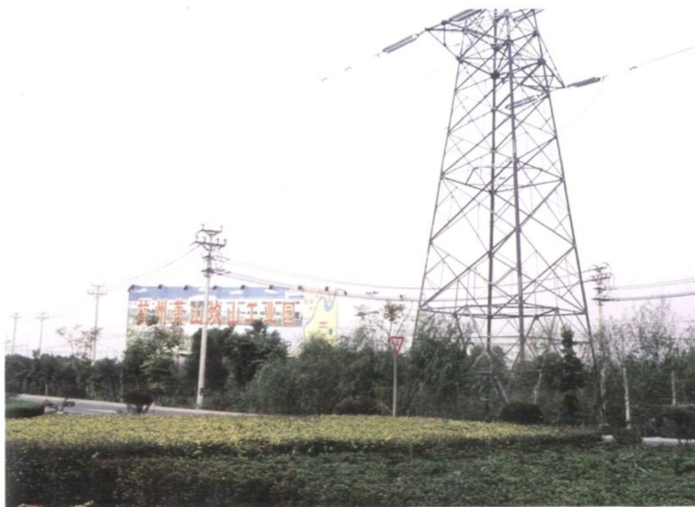
建设中的坎山工业园
