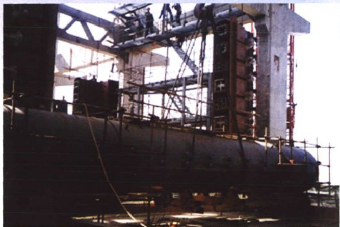
2003年10月29日，江苏射阳港发电有限责任公司 二期工程4号炉汽包起吊
