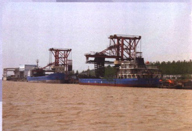
煤码头和链斗卸船机 (摄于2005年4月30日)
