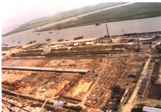
江苏射阳港发电有限责任公司一期工程土建施工现场鸟瞰（摄于1993年9月23日）
