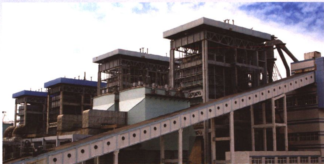
锅炉（摄于2005年5月15日）
