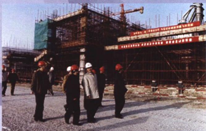
2003年4月20日，江苏射阳港发电有限责任公司 二期工程主厂房土建工程施工现场
