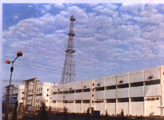
220 千伏开关室 (摄于1996年1月5日)
