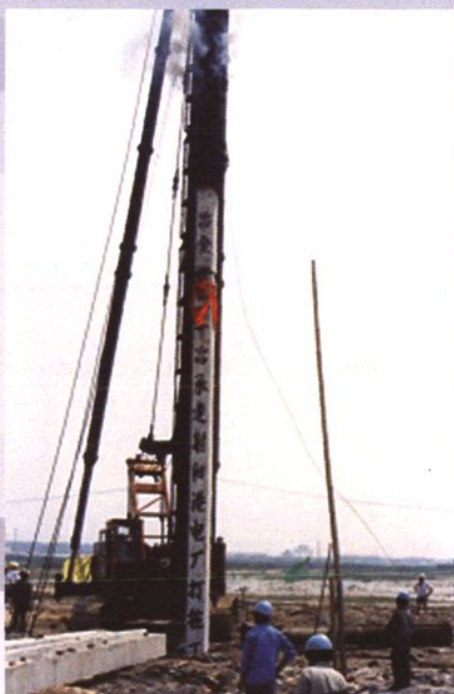
1992年7月25日，江苏射阳港发电有限责任公司一期工程打桩
