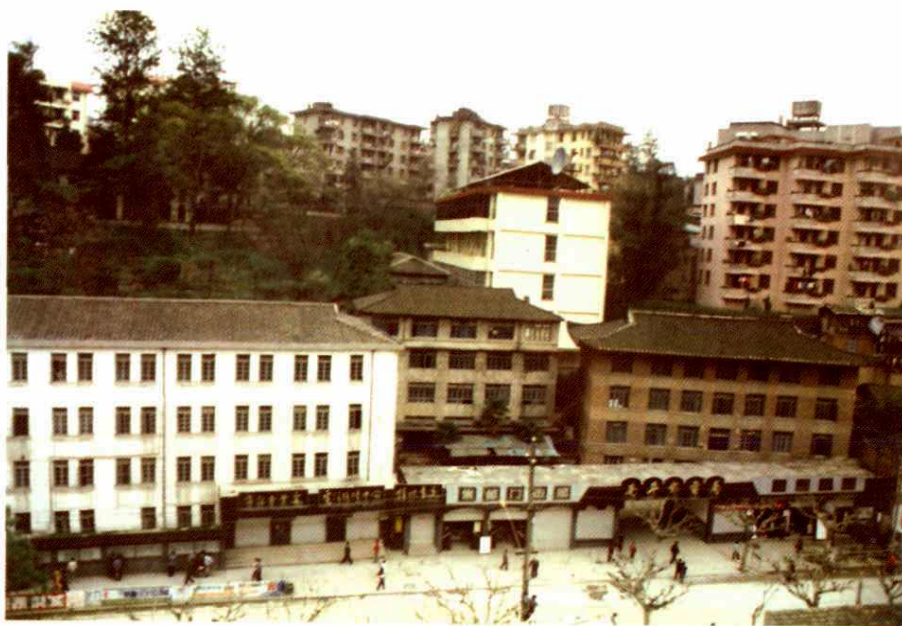
原南平地区邮电局办公楼
