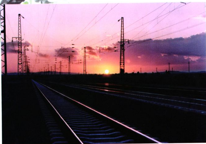
大同—秦皇岛复线电气化铁路阳原段
