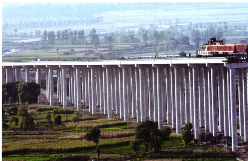
建设中的张北—石家庄高速公路 阳原桑干河特大桥
