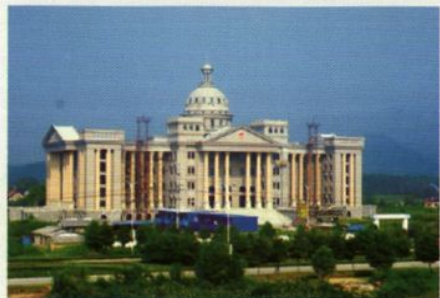
即将竣工的市法院审判综合大楼
