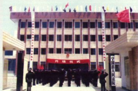
1992年县法院办公楼
